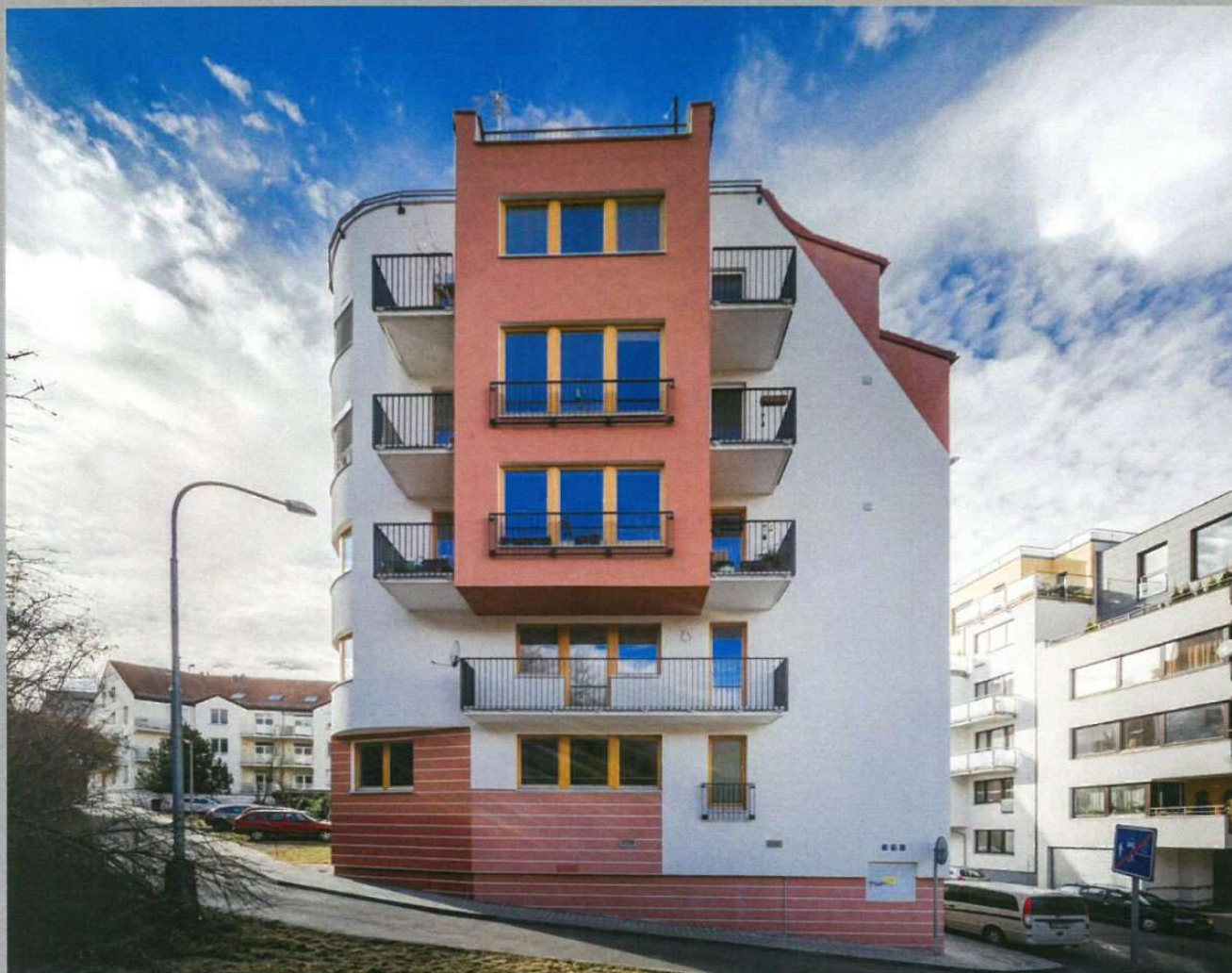
Panelový dům Musílkova 1308, Praha 5, odřasení a ochranné nátěry
