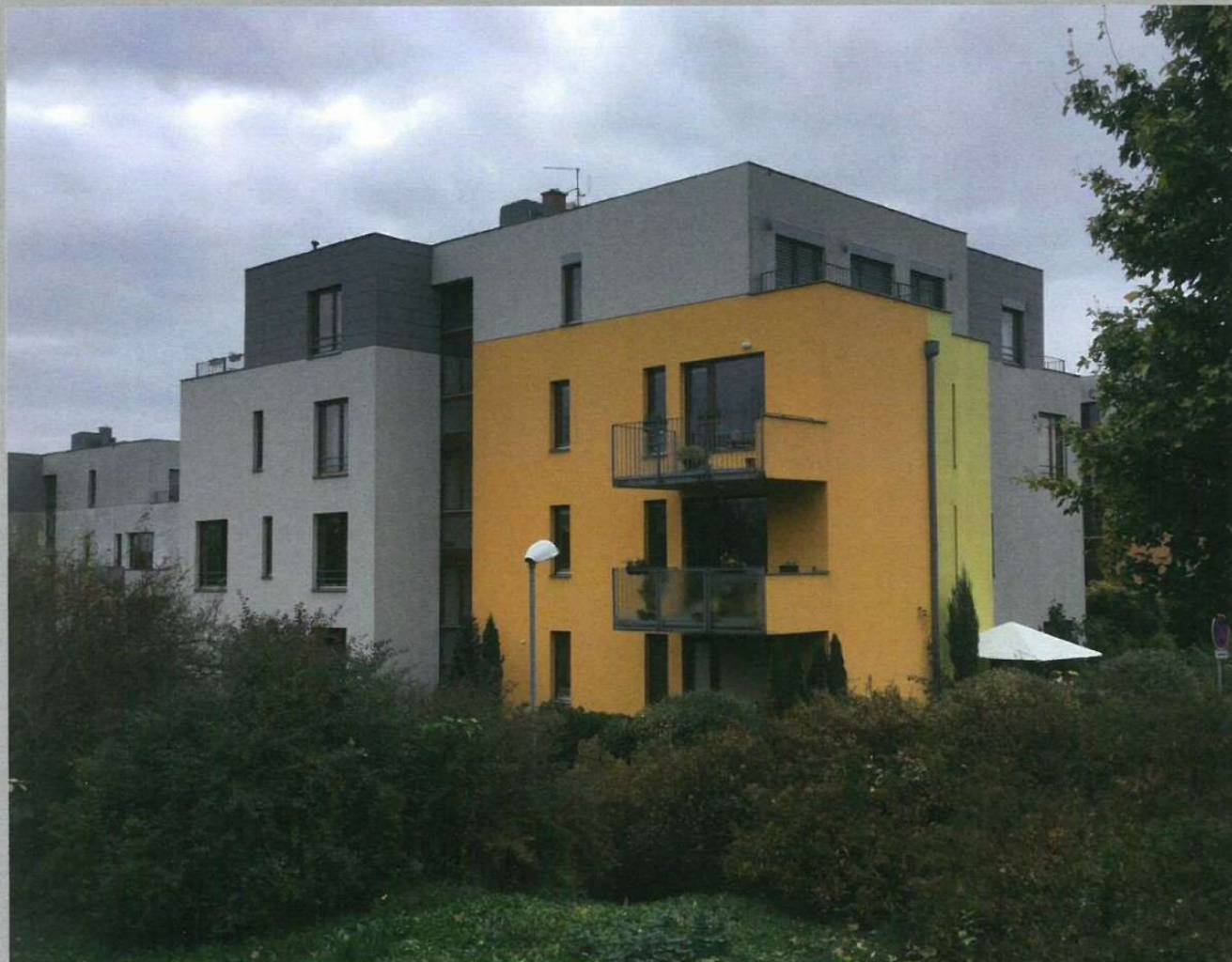
Panelový dům Kamýcká 243, Praha 6, odřasení a ochranné nátěry
