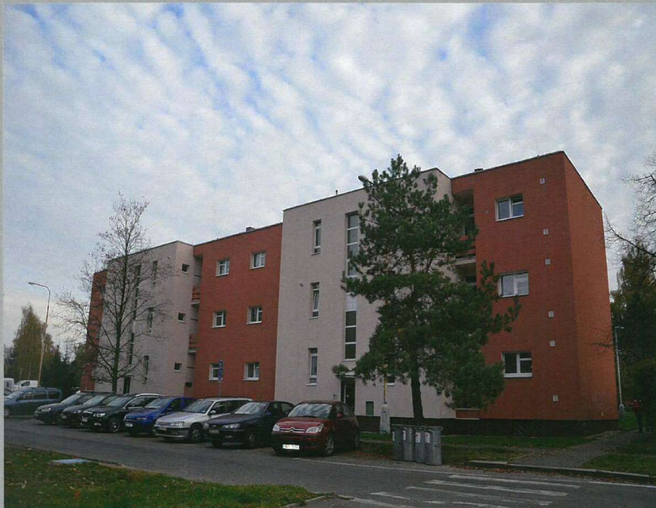
Panelový dům Římská 659 a 631, Kladno, odřasení a ochranné nátěry
