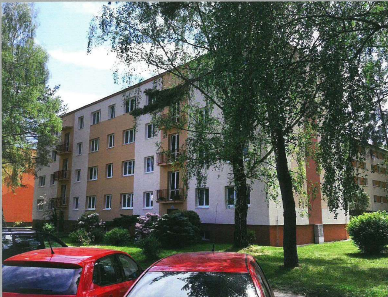
Panelový dům Brjanská 3013 - 3014, Kladno, odřasení a ochranné nátěry
